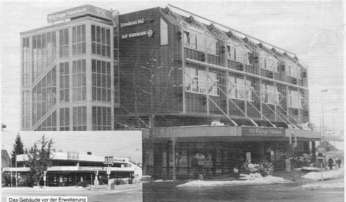
Das Gebäude vor der Erweiterung
